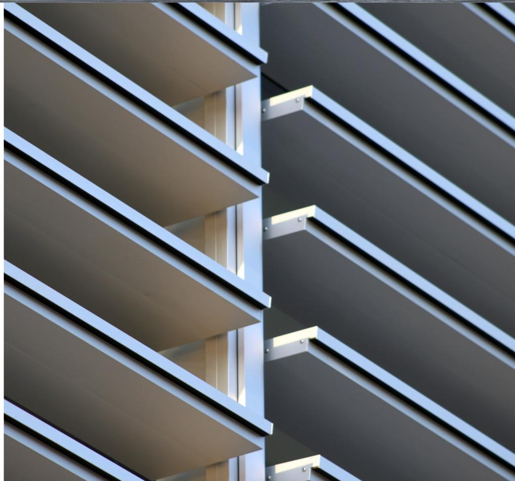
Quer na vertente manual quer na motorizada, o controlo da radiação solar no interior dos edifícios é total, permitindo abrir até 90° ou fechar as lâminas, consoante a necessidade de iluminação. As lâminas podem ser aplicadas tanto na vertical como horizontalmente.
